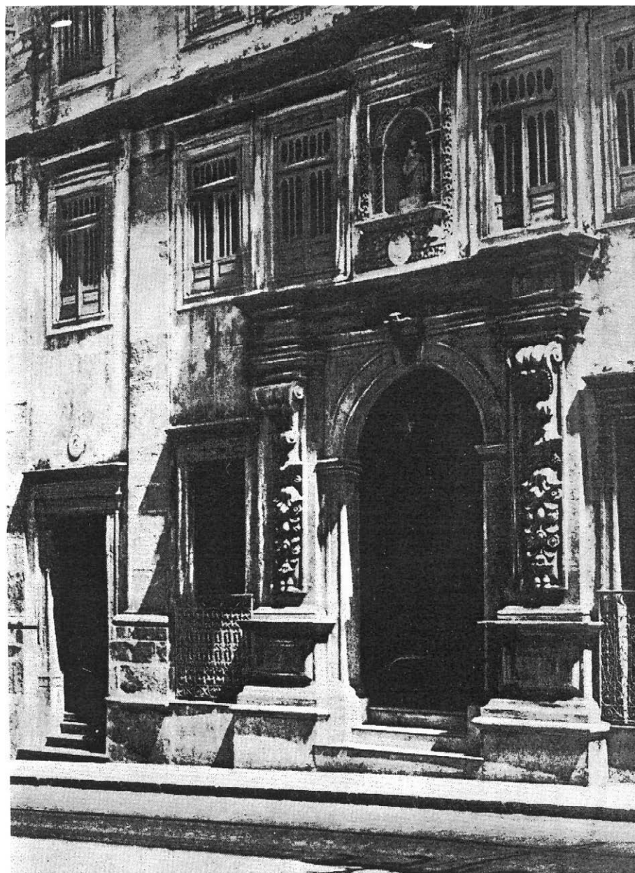
Santa Casa da Misericórdia na Bahia – Pormenor da fachada da capela. In Relíquias da Bahia, de Edgard de Cerqueira Falcão.
