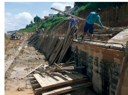
Obra de contenção de erosão e revitalização da orla do município de Borba
