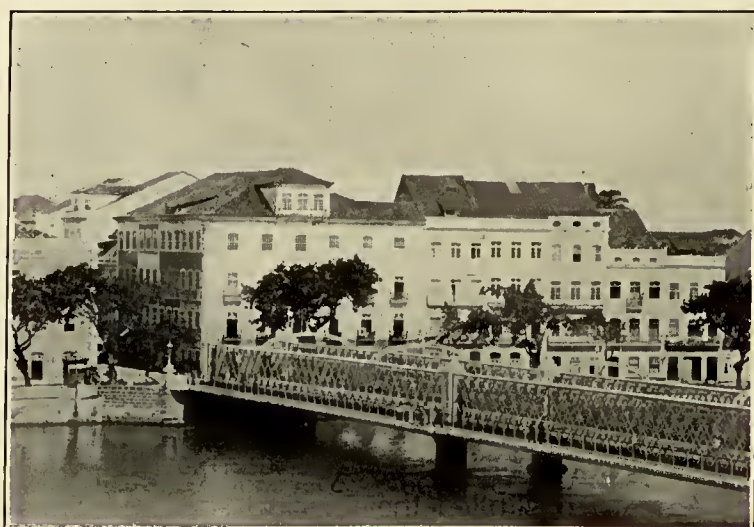
PONTE DE BOA VISTA, PERNAMBUCO.
