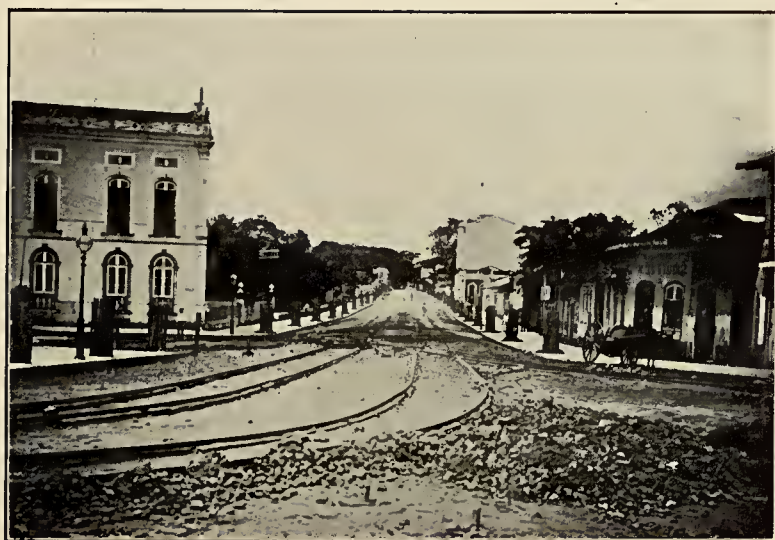
ESTRADA DE NAZARETH, PARÁ.
