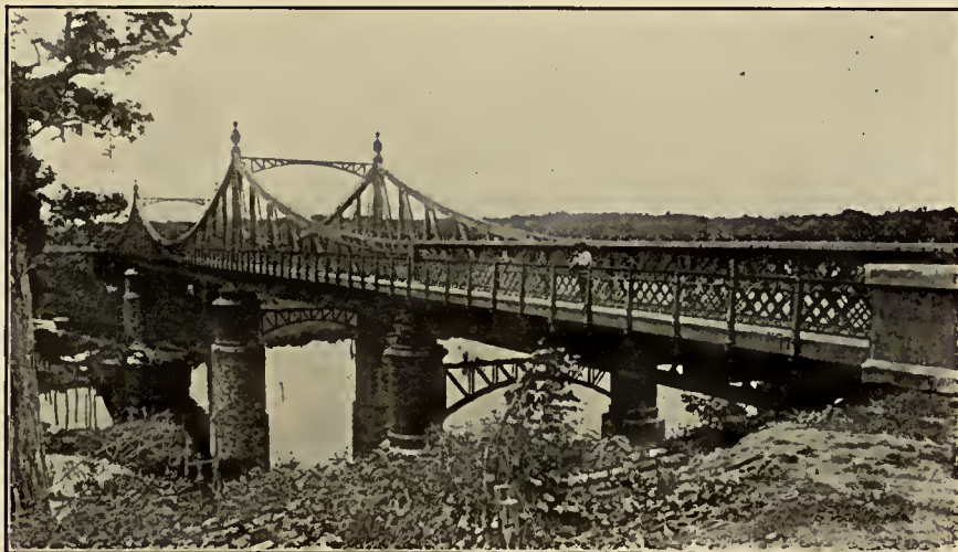
BRIDGE AT CACHOEIRINHA, MANÃOS.
