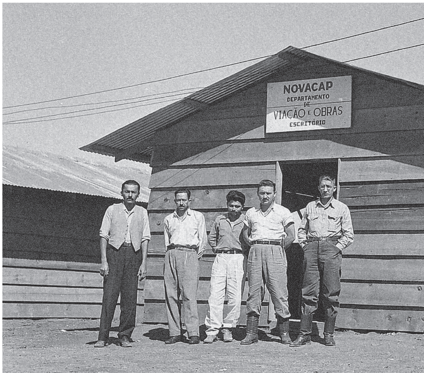
Construção de Brasília (1958).
