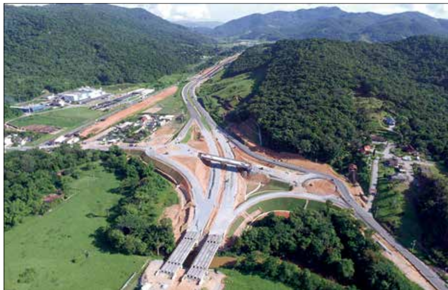
Viaduto em obras é uma das seis interseções ao longo do Contorno Viário de Florianópolis
