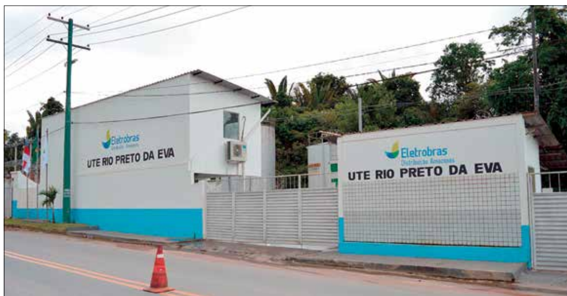
Usina termelétrica na cidade de Rio Preto da Eva (AM): medida dá condições para privatizar a Amazonas Energia
