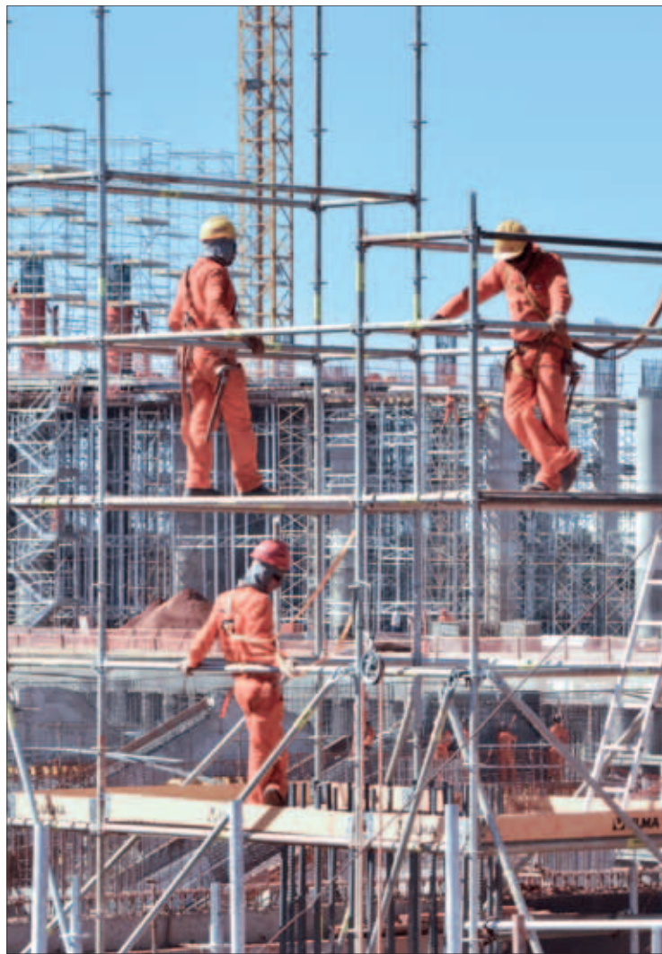
Trabalhadores usam equipamentos de segurança em obra de estádio em Brasília
