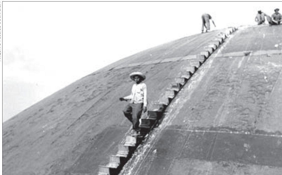
Operários trabalham na construção da cúpula do Senado, em Brasília, durante o governo de JK
