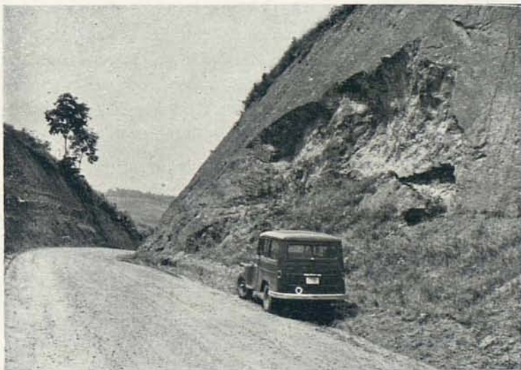
Figura 31 — Litossolo de Mica. Visto, ao norte de Anápolis, logo ao sul da usina hidrelétrica. Profundidade típica de intemperização do «bedrock». Não há rocha fresca no corte. Note-se o desmoronamento do talude do corte. A análise aerofotográfica identificou centenas de sérios desmoronamentos em áreas de Micaxisto. Ver sobrecapa de geologia e seção de Engenharia deste relatório
