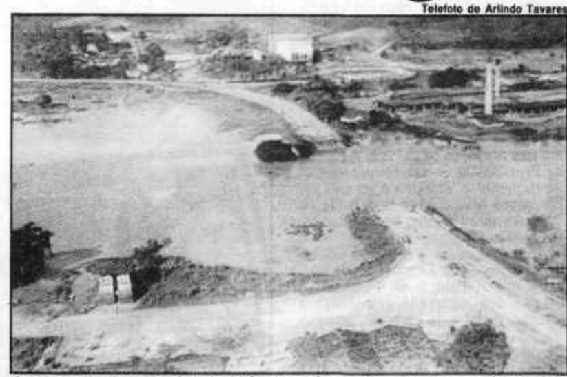
A ponte que leva ao Sul do País destruída pela enchente no Rio Paraíba
