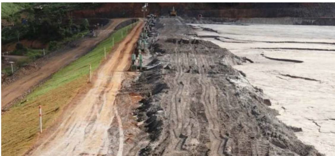
Figura 8 – Primeiro alteamento da barragem do Fundão 17 .
