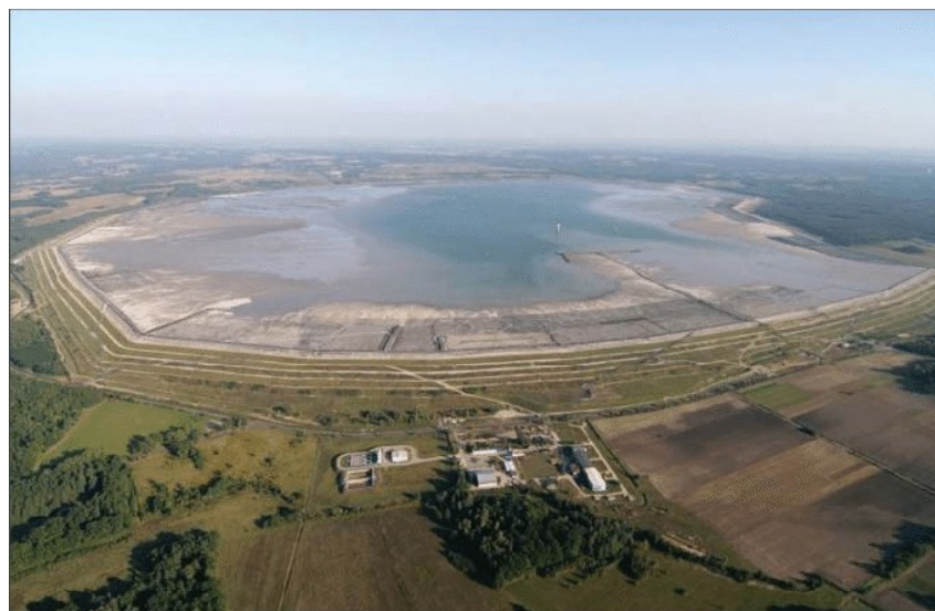
Figura 7 – Formação de lagoa de decantação no interior de barragem de rejeitos de mineração 15 .
