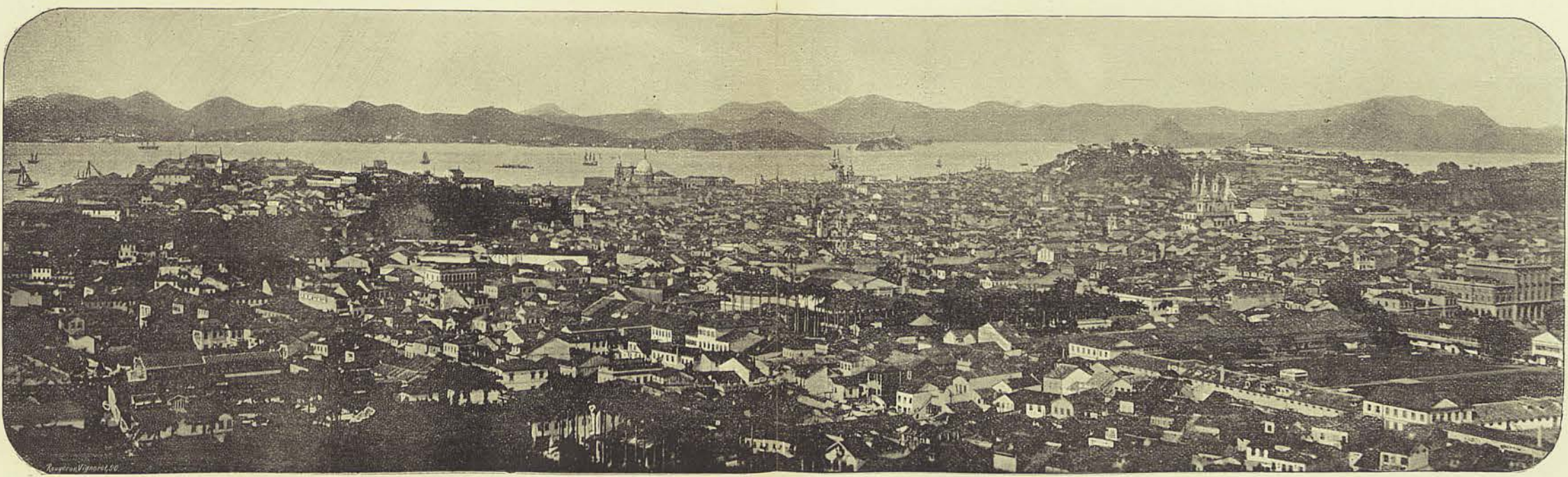
Colline St-Bento. Sur la rive opposée, la ville de Nietheroy. Egl. Candelaria. S. Domingos. Boa-Viagem et la plage d'Icarahy. Colline du Castello.
