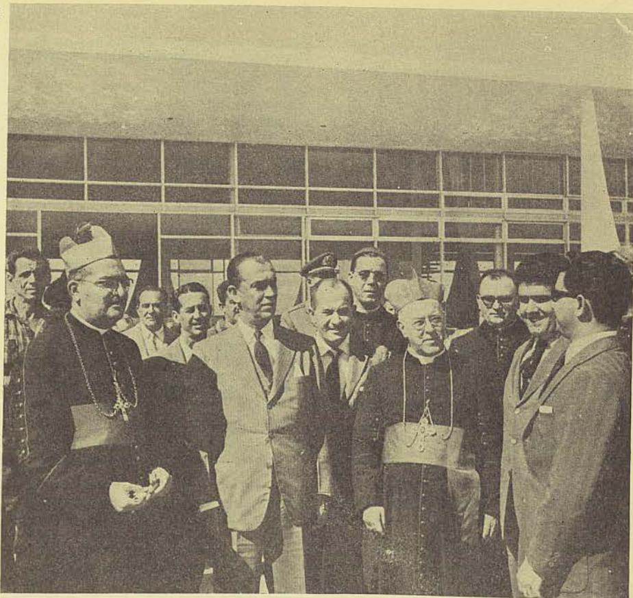
20. Descarregamento das vigas metálicas em Brasília. 21. Altos dignitários da Igreja em visita ao Palácio da Alvorada.
