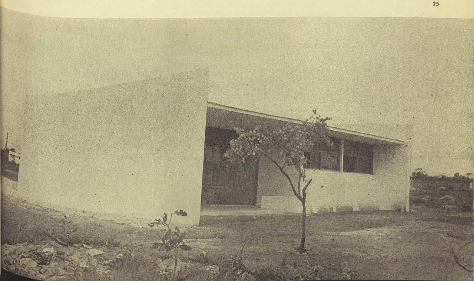
25. Uma das casas construídas pela Novacap.
