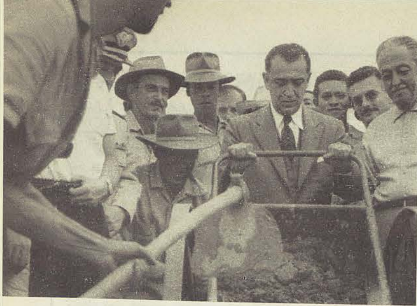
● S. Exa. faz questão de despejar, êle mesmo, uma carrada de concreto...
