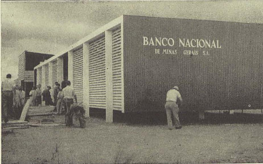
3 — Os escritórios da Companhia Urbanizadora já em fase de conclusão. Amplas salas e disposições adequadas à entrosagem racional dos serviços. O edifício, de madeira, é armado em estrutura metálica.
