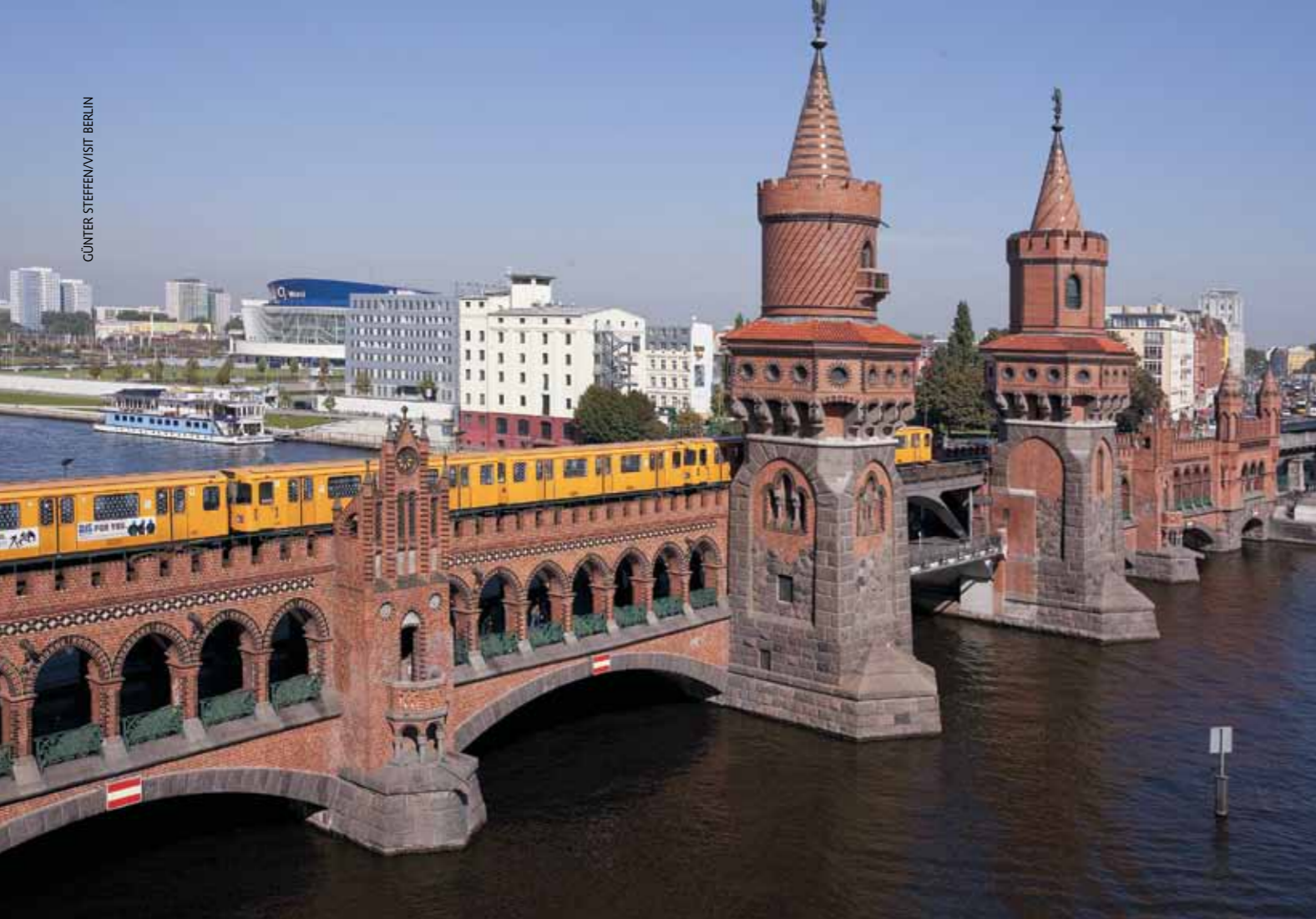
VLT cruza ponte de piso duplo sobre o Rio Spree, em Berlim: reunificação foi seguida de projeto de integração dos transportes
