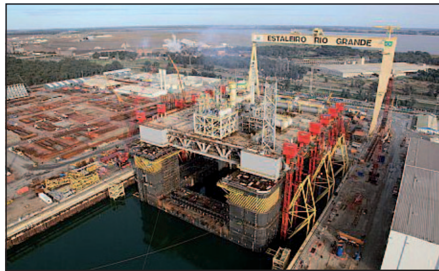
Construção da Plataforma P-55 em Rio Grande (RS)
