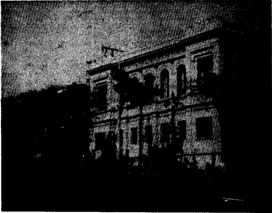
Este prédio, situado na Av. João Pinheiro, 342, em Belo Horizonte (atual Inspetoria-Geral de Finanças), foi a sede do Senado estadual, até 1930
